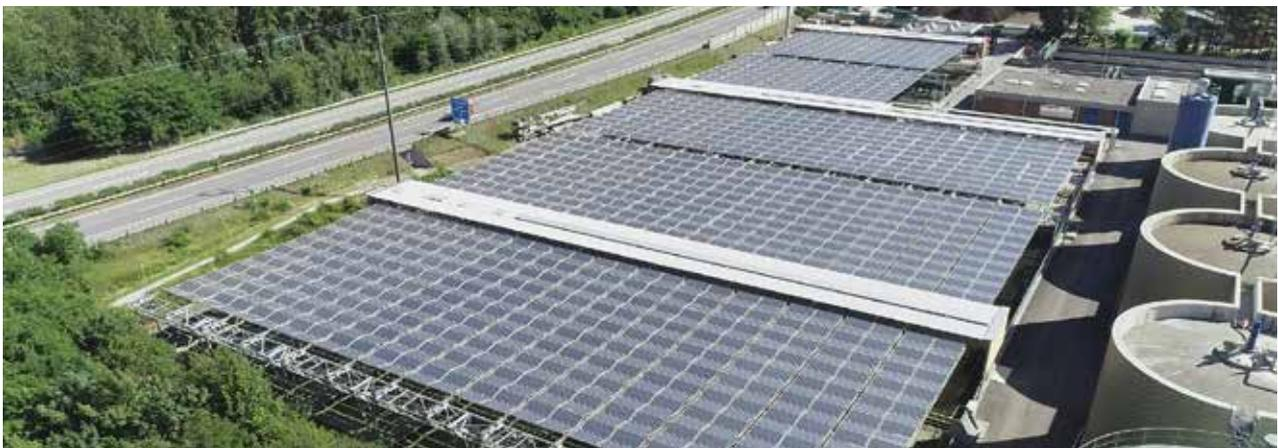
Industrie stark erhöht und soll über Effizienzmassnahmen und Eigenproduktion von Energie teilweise kompensiert werden. Das Solarfaltdach ermöglicht mit der Doppelnutzung der offenen Klärbeckenflächen eine Erhöhung der Eigenversorgung mit Solarstrom um durchschnittlich ca. 50%. Zusätzlich ist das Solarfaltdach perfekt geeignet für das Zusammenspiel mit den oftmals vorhandenen Blockheizkraftwerken.
