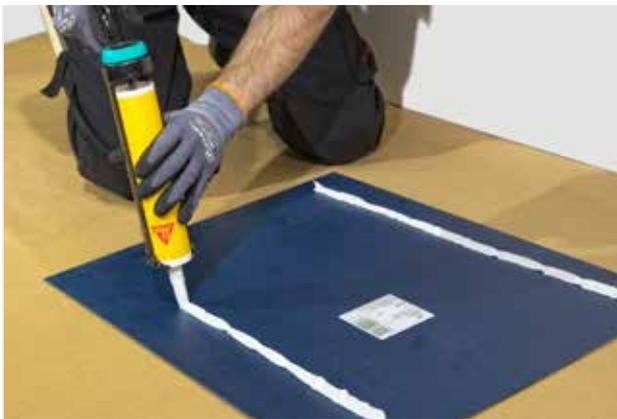
Je nach Untergrund (Beton, Metall, Holz) ermöglicht die Palette der Sika-Klebstoffe eine sichere Fixierung oder Abdichtung der Ausbauelemente oder eine strukturelle Verklebung mit stabilen Eigenschaften.
