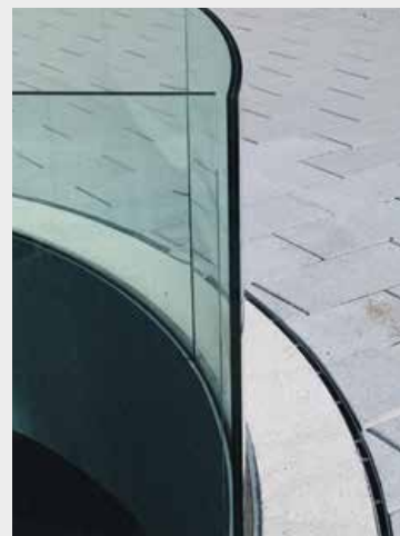
Encastrement rapide et sans contrainte de balustrades incurvées
