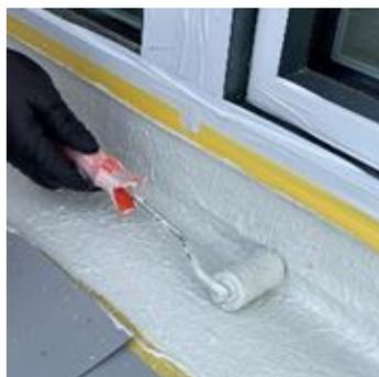
Applicare nuovamente del Sikalastic®-625 N sulle fibre sollevate, sui fori o sulle aree esposte.
