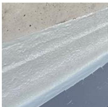
**Avvertenza:** verificare nuovamente l'applicazione del materiale sintetico liquido per assicurarsi di aver trattato l'intera superficie e che il non-woven sia completamente allettato!
