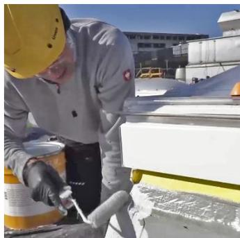
Applicare il 1° strato di Sikalastic®-625 N con un consumo minimo di 1.0 l/m<sup>2</sup> (1.25 kg), assicurandosi che la mano di lavoro sia sufficiente e regolare.
