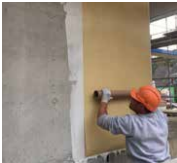
Étanchéité appliquée ultérieurement
