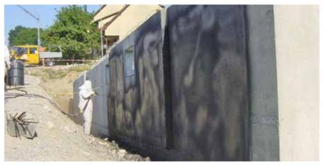
Auftrag von kunststoffmodifizierter Bitumendickbeschichtung
