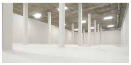
Zementgebundene Beschichtung als Reservoirauskleidung
