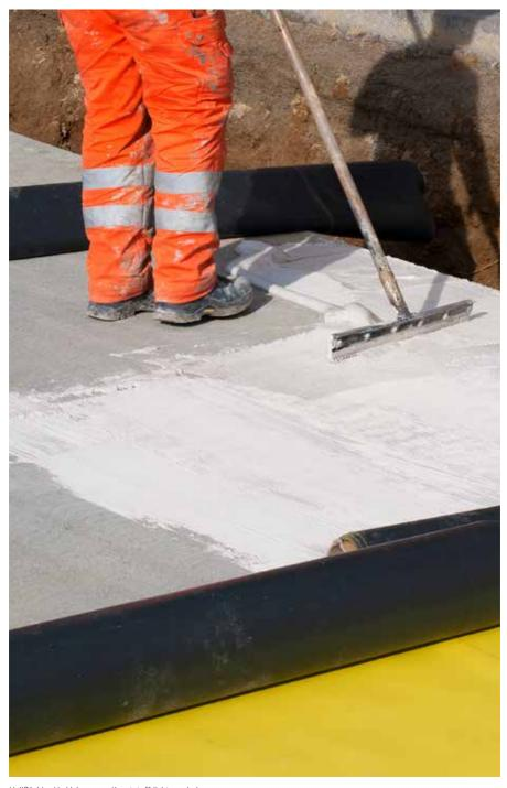
Vollflächige Verklebung von Kunststoffdichtungsbahnen
