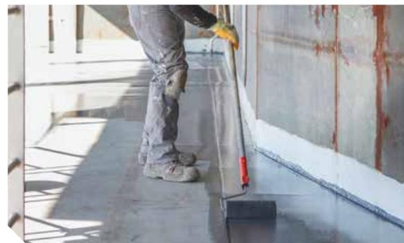
Application de SikaCor® ZP Primer avec un rouleau sur un pont en acier.
