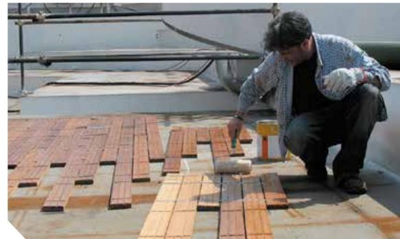
Application de Sika® MultiPrimer Marine au rouleau sur un pont en teck (face arrière)
