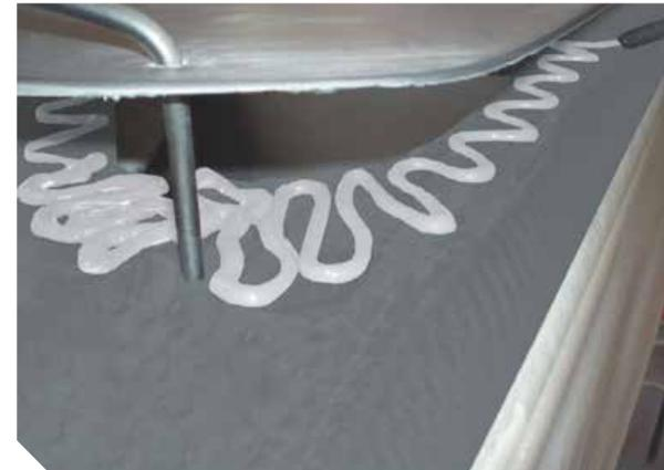
Une tige de fixation permet d'orienter le cordon de colle avec précision
