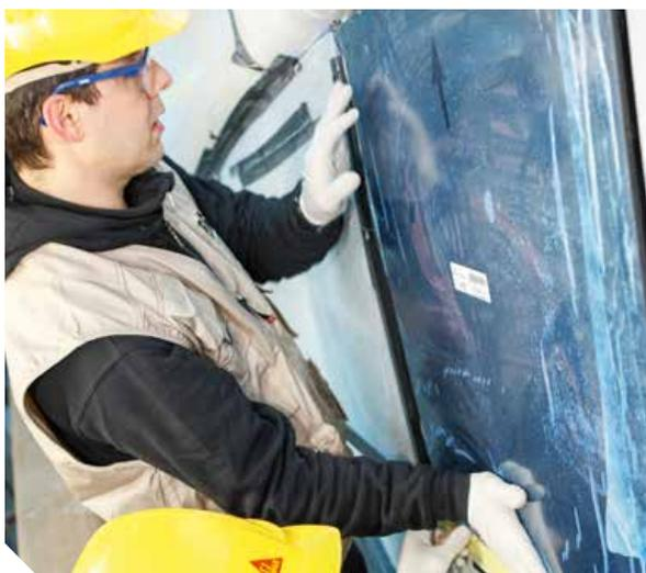
Le disque peut encore être aligné directement après l'assemblage
