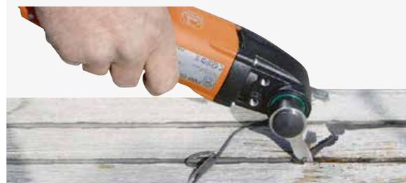
3 Le matériau d'étanchéité découpé est retiré du joint sous forme de bande continue.
