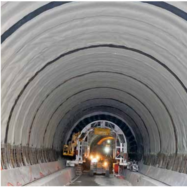
Um das Tunnelbauwerk vor Wassereintrag zu schützen, setzte die SikaBau AG als Verarbeiter die Systemlösung SikaProof®-200 als "Regenschirm"-Abdichtung ein.
