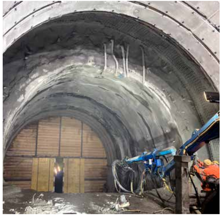
Im Frühjahr 2017 wurden die Vortriebsarbeiten mit einer aufwändigen Ausbruchsicherung mit Stahlträgern und bewehrten Ortbetonringen erneut aufgenommen. Im bereits ausgebrochenen Abschnitt wurde das Profil aufgeweitet.
