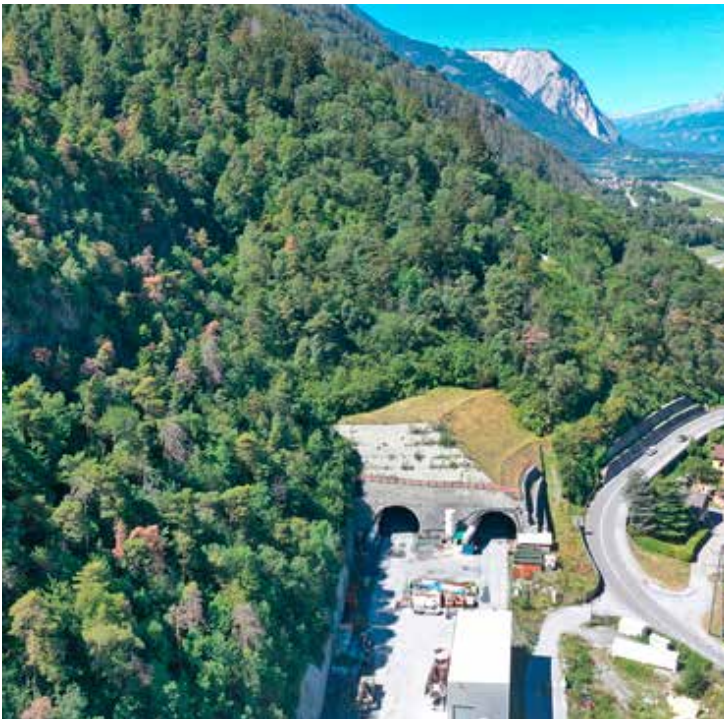
Die bautechnischen Herausforderungen beim Tunnel Riedberg an der Autobahn A9 sind hoch. Die Eröffnung der 500 m langen Röhren ist voraussichtlich 2026 geplant. (Foto: www.a9-vs.ch)
