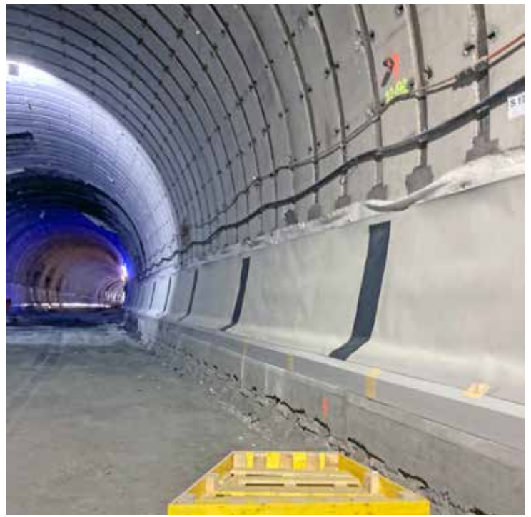
Im Frühling-Sommer 2022 wurden die Drainagewinkel für die Entwässerungsleitungen verlegt, kurz danach erfolgte die Drainage und Abdichtung mit SikaProof®-200.
