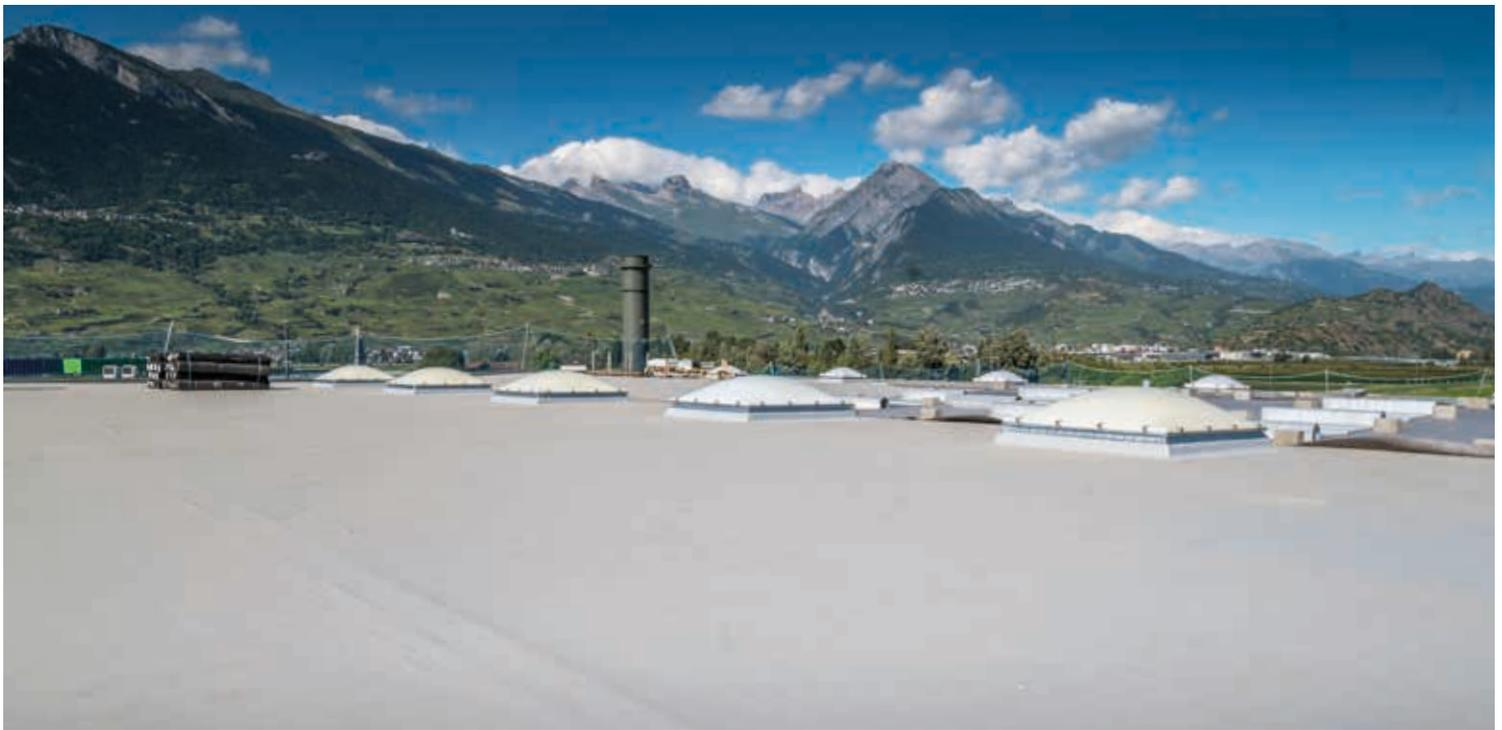
TPO-Kunststoffbahnen sind deutlich leichter als Bitumen-Lösungen. Die Belastung am Dach so gering wie möglich zu halten, war entscheidend für die leichte Holzkonstruktion.
