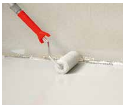
Appliquer la 2ème couche de Schönox® EA PUR au moyen d'un rouleau dans un délai de 12 - 24 heures.
