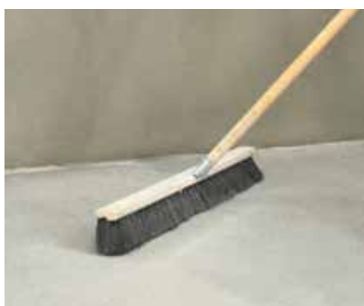
Aspirer/balayer le surplus de sable de quartz sur la surface complètement sèche.
