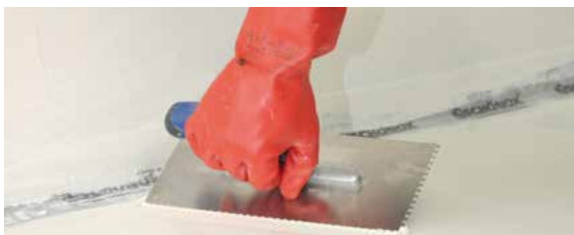
Appliquer l'étanchéité polyuréthane Schönox® EA PUR au moyen d'une truelle denture 6.
