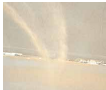
Saupoudrer la surface avec Sika® sable de quartz 0.3 - 0.9 mm pendant que le matériau est encore frais et après séchage aspirer/balayer.
