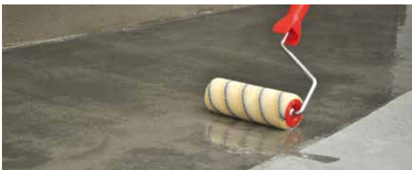
Appliquer la couche de fond de Sikafloor®-160 à l'aide d'un rouleau à poils courts.
