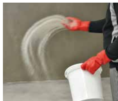
Saupoudrer la surface ayant reçu la couche de fond avec Sika® sable de quartz 0.3 - 0.9 mm).
