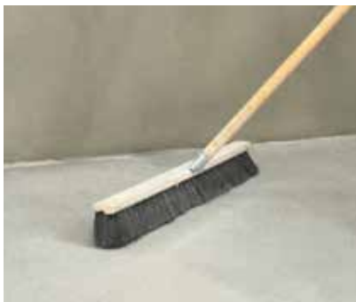
Absaugen/abkehren des überschüssigen Quarzsandes auf der durchgetrockneten Fläche.
