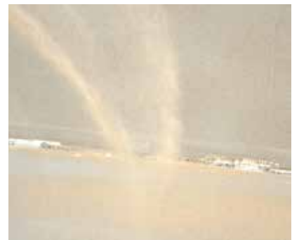
Die Fläche in der Frischphase des Material mit Sika® Quarzsand 0.3 - 0.9 mm absanden und nach Trocknung absaugen/abkehren.
