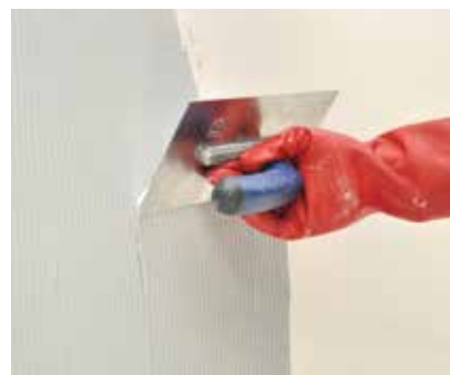
Innerhalb von 12 - 24 Std. die 2. Lage Schönox® EA PUR S mit einer 4er Zahnung auftragen.
