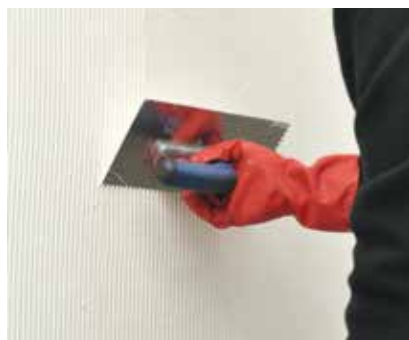
Die Polyurethan Abdichtung Schönox® EA PUR S mit einer geeigneten Glätt- oder Zahnkelle (z.B. 4 mm) aufbringen.
