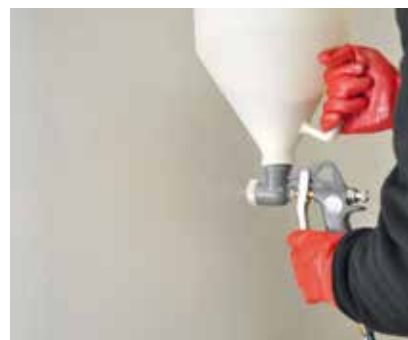
Die Fläche in der Frischphase des Materials mit Sika® Quarzsand 0.3 - 0.9 mm absanden.
