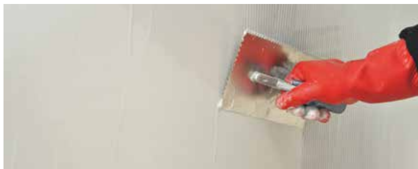
Auch die 2. Schicht Schönox® EA PUR S mit einer Kelle abglätten und die Schichtdicke prüfen.
