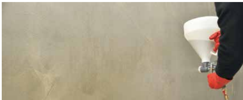
Absanden der grundierten Fläche mittels Trichterpistole mit Sika® Quarzsand 0.3 - 0.9 mm.
