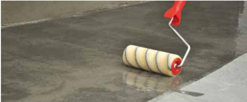
Die Grundierung Sikafloor®-160 mit einer Kurzfloorrolle aufbringen.
