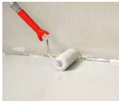
Innerhalb von 12 - 24 Std. die 2. Lage Schönnox® EA PUR mit einer Rolle auftragen.
