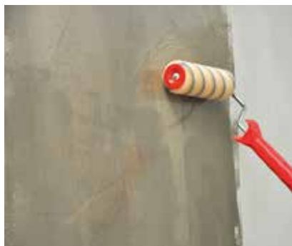
Die Grundierung Sikafloor®-160 mit einer Kurzflorrolle aufbringen.
