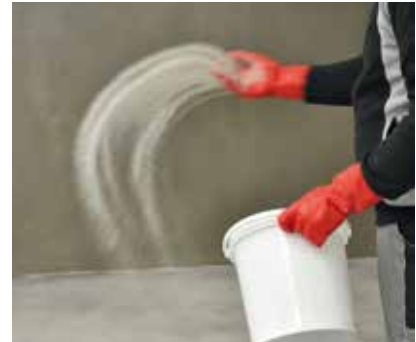
Die grundierte Fläche mit Sika® Quarzsand 0.3 - 0.9 mm absanden.
