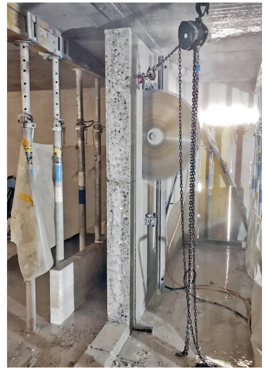
Foto Betonkreissäge: Diamcoupe SA Restliche Fotos: SXL / EPFL
