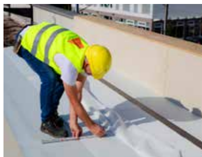
2. Segnare l'altezza del bordo superiore del cordolo.
