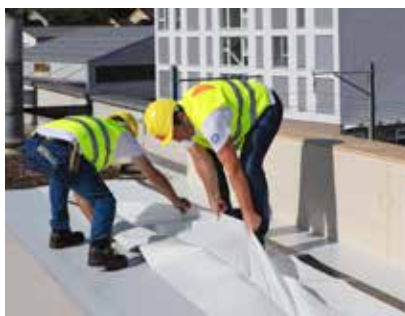
1. Posizionare SikaRoof AT FSA P e togliere la pellicola protettiva.
