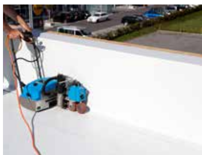
5. Raccordo tramite saldatura termica con il manto sintetico del tetto.
