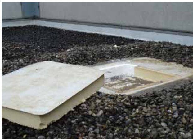
La structure du toit est entièrement sèche
