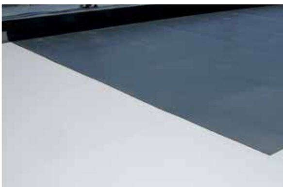
La membrane de protection recyclée protège l'étanchéité de la toiture contre les dégâts mécaniques.
