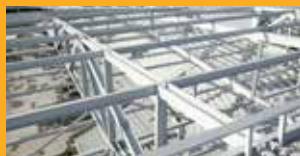
PROTECTION ANTICORROSION ET PROTECTION IGNIFUGE
