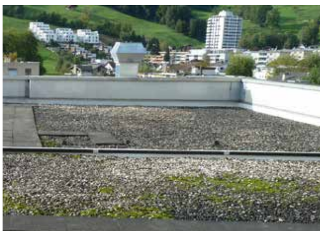
Première toiture Sarnafil® T en Europe: Sarnen 1988
