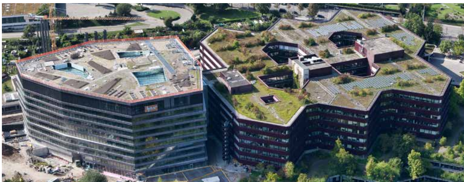
A droite: Toiture Sarnafil âgée de plus de 20 ans | A gauche: Nouvelle toiture Sarnafil
