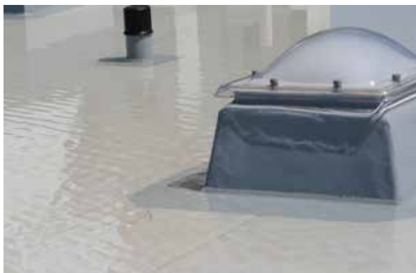
La mise en eau offre une sécurité supplémentaire pour le contrôle de l'étanchéité lors de la réception de la toiture.
