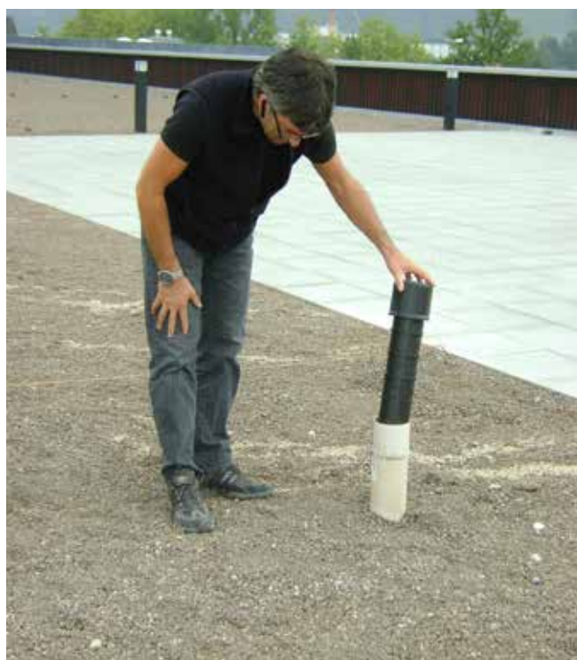
Le tuyau de contrôle garantit à tout moment un accès à la structure du toit et permet de reconnaître à temps d'éventuelles infiltrations.
