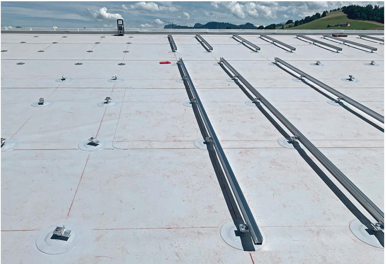
SikaRoof®Anchor, fixiert und verschweisst auf die Hybrid FPO-Kunststoffdichtungsbahn Sarnafil® TS 77-18.
