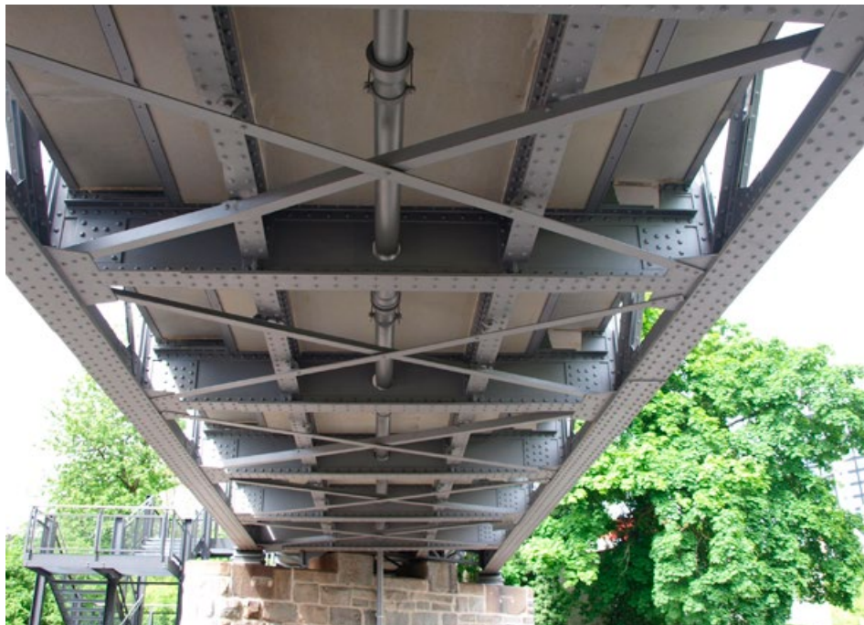
Vue du dessous du pont après l'assainissement complet.
