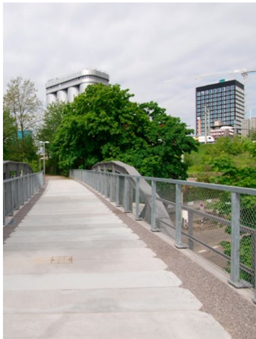
Renouvellement du tablier de pont et des rambardes.
