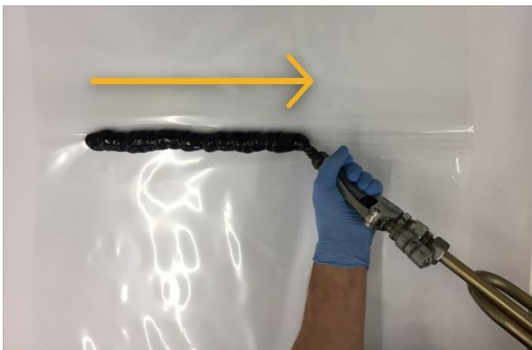
BILD 9 Klebstoffraupe in Richtung des Falzes auftragen
