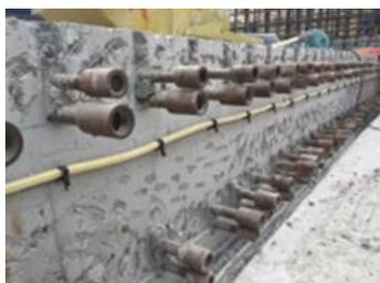
Per la sigillatura preliminare dei giunti di lavoro, utilizzare sempre SikaSwell® (soluzione per un'impermeabilizzazione complementare minima). Per i progetti con requisiti elevati (classe di impermeabilità 1) utilizzare il sistema SikaFuko® oppure Sika Waterbar®.
