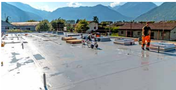
SikaRoof® AT konnte dank den praktischen Rollen schnell ausgerollt und das Dach so in kurzer Zeit abgedichtet werden.
