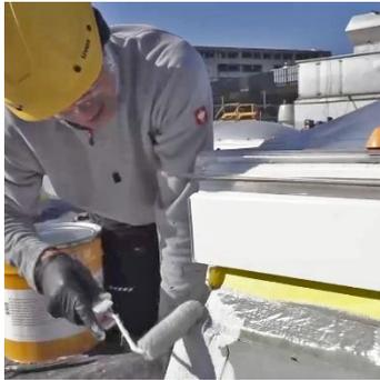
Appliquer la 1re couche de Sikalastic® Rapid-722 Detail avec au min. 1.5 kg.
