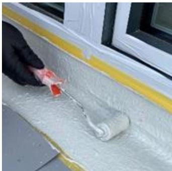
Repasser une nouvelle couche de Sikalastic® Rapid-722 Detail sur les fibres qui dépassent, les trous ou les zones exposées.
