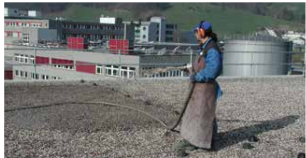
Anspritzbegrünung | Semis hydraulique
