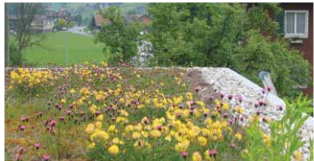
Dachbegrünung mit Kräutermischung | Végétalisation avec un mélange d'herbes sauvages
