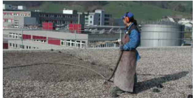
Anspritzbegrünung | Semis hydraulique
