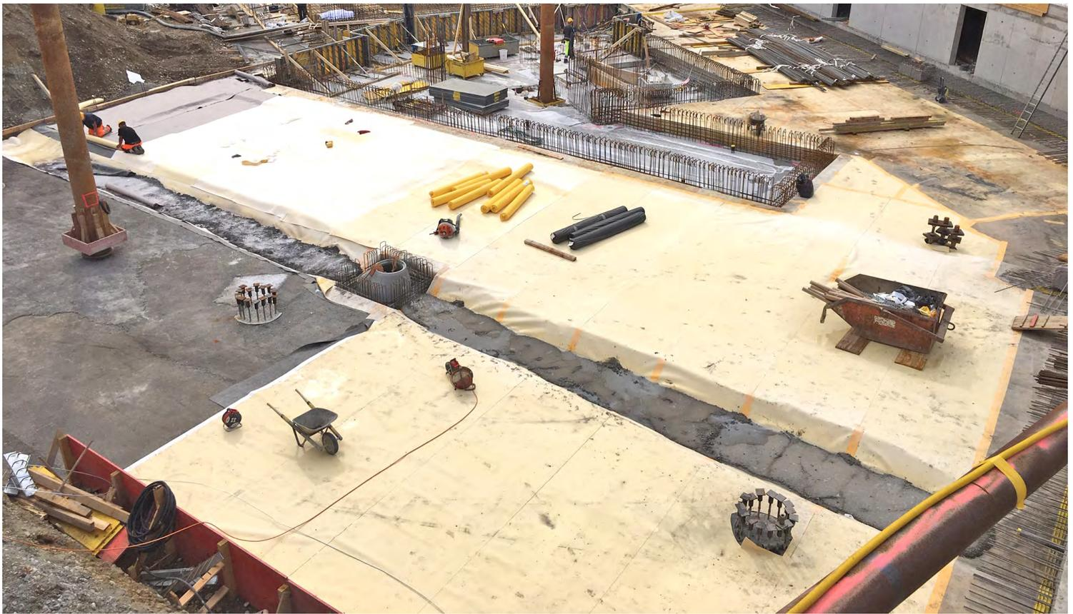
Abdichtungsmembran ein. Das heisst, dass bei kleinen Beschädigungen der Membran das Wasser sich nicht zwischen Beton und Membran unerwünscht ausbreiten kann.
