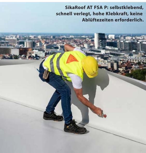
**SikaRoof AT – die TPO-Abdichtung der neusten Generation bleibt auch bei kalten Jahreszeiten flexibel und dichtet Dachflächen sicher ab.**
