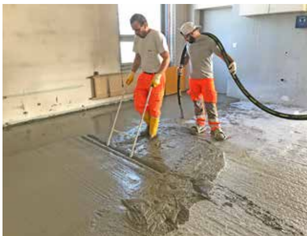
Application depuis une posture droite qui soulage le corps grâce à la barre à débuller Plus de tiré à la règle sur les genoux
