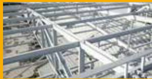
PROTECTION ANTICORROSION ET PROTECTION IGNIFUGE
