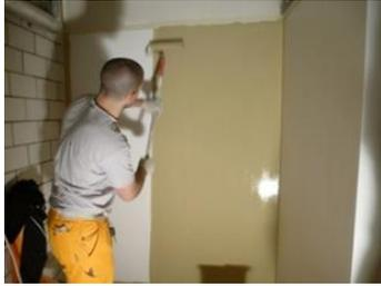
Je nach Deckkraft 2 - 3-mal die pigmentierte Beschichtung Sikafloor®-302 W+ (farbig) auftragen. Dazwischen Feinschliff mit 220er und 500er Papier möglich.
