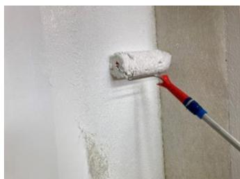
Überschichten des Glasfasergeleges, bis alle Glasfasern komplett mit Harz benetzt sind.
