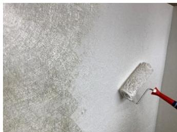
Applikation des Harzes mit geeigneter Walze bis alle Glasfasern benetzt sind. Die Ausrichtung der Walze bei Applikation so wählen, dass im Gelege keine Falten entstehen.
