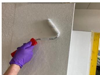
Applikation von Sikagard®-403 W mit geeigneter Walze bis alle Glasfasern benetzt sind. Für diesen Arbeitsgang empfiehlt sich die Verwendung einer Walz mit 13 mm Schurhöhe.
