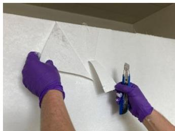
Die zugeschnittenen Reststücke des Sika® Reemat Lite entfernen. Zum Entfernen des verdeckten Reststücks muss das Sika® Reemat Lite angehoben und dann das Reststück vorsichtig rausgezogen werden. Danach das Harz mit geeigneter Walze wieder verschlichten, bis alle Glasfasern benetzt sind.
