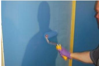
Je nach Deckkraft 2 - 3-mal die pigmentierte Beschichtung Sikafloor®-302 W+ (farbig) auftragen. Dazwischen Feinschliff mit 220er und 500er Papier.
