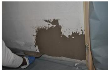
Die gebrauchsfertige Dichtungsschlämme in min. 2 Arbeitsgängen in jeweils gleicher Konsistenz und Schichtdicke (ca. 1 - 2 mm pro Schicht) mit Traufel (evtl. auch Pinsel oder Roller) gleichmässig auftragen. Die Schichtdicken sind auch bei Ecken und Kanten unbedingt einzuhalten.
