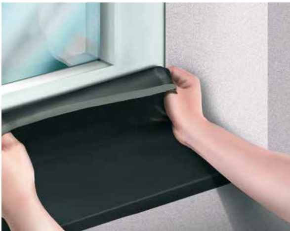
SikaMembran®-Folie auflegen
