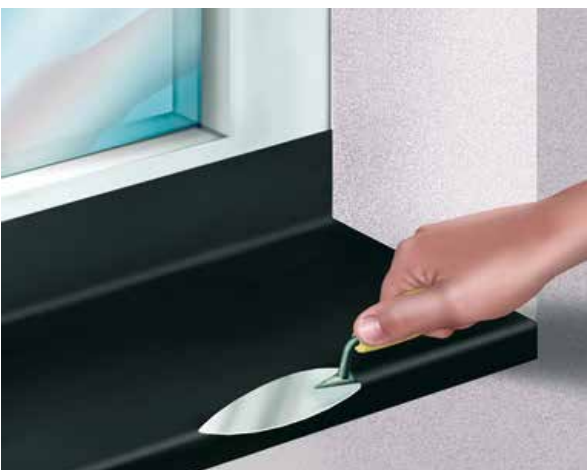
Folie in überschüssigen Klebstoff einbetten
