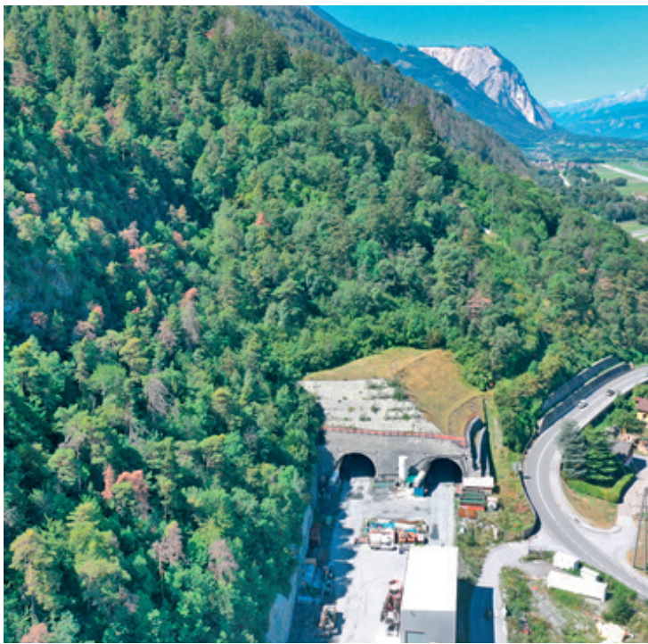
Les défis techniques liés à la construction du tunnel de Riedberg sur l'autoroute A9 sont importants. L'ouverture des tubes de 500 m de long est prévue pour 2026. (Photo: www.a9-vs.ch)
