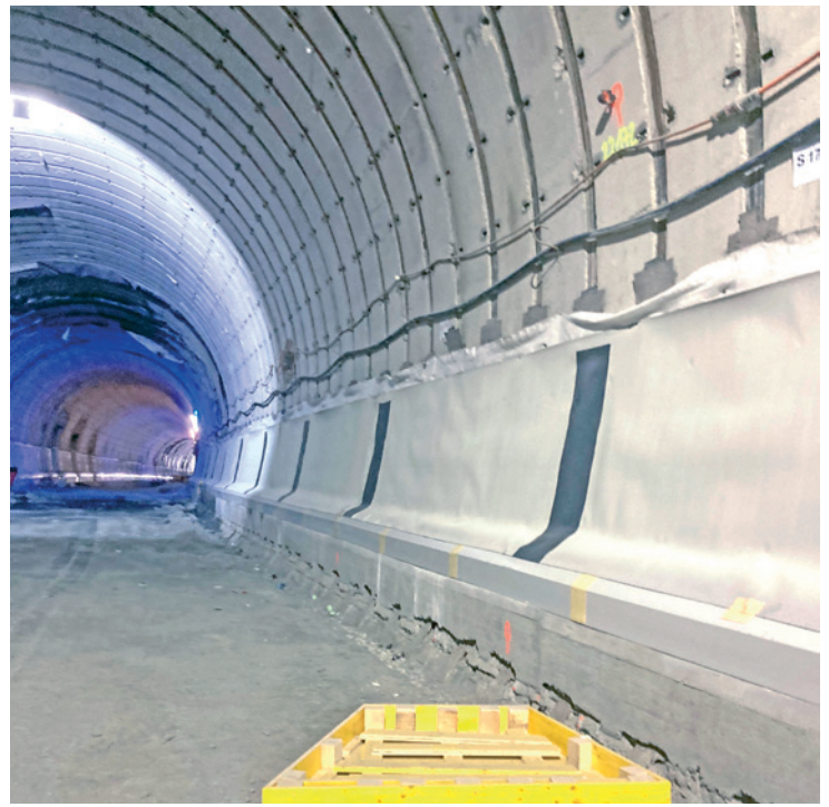
Au printemps-été 2022, les angles de drainage ont été posés, suivis peu après par le drainage et l'étanchéité SikaProof®-200.
