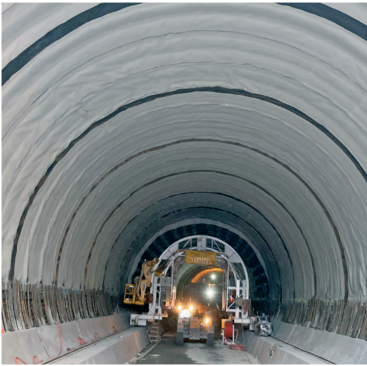
Afin de protéger l'ouvrage contre les infiltrations d'eau, SikaBau AG a mis en place le système SikaProof®-200 comme étanchéité "parapluie".
