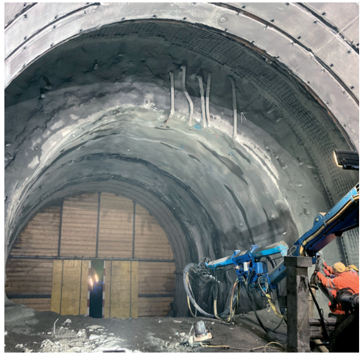
Au printemps 2017, les travaux de percement ont repris avec la mise en place d'un dispositif de protection complexe comprenant des poutres en acier et des anneaux en béton armé coulés sur place. Dans la section déjà excavée, le profil a été élargi.
