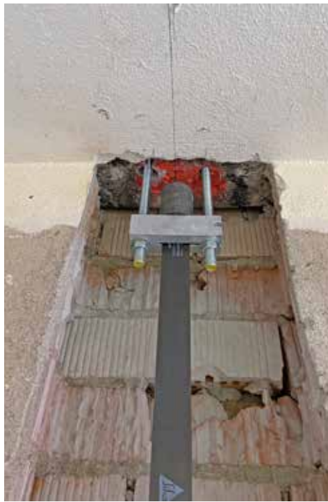
Die Kohlefaserlamellen wurden der Zwischendecke endverankert
