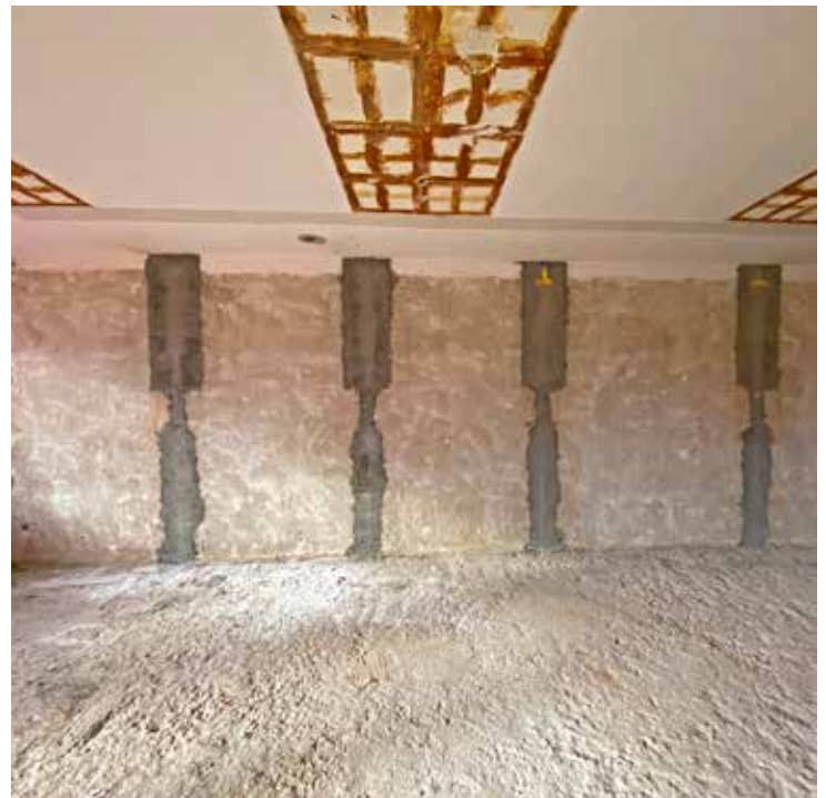
Fertig installiert, sind die CarboStress Systeme eingemörtelt und werden ins Mauerwerk integriert
