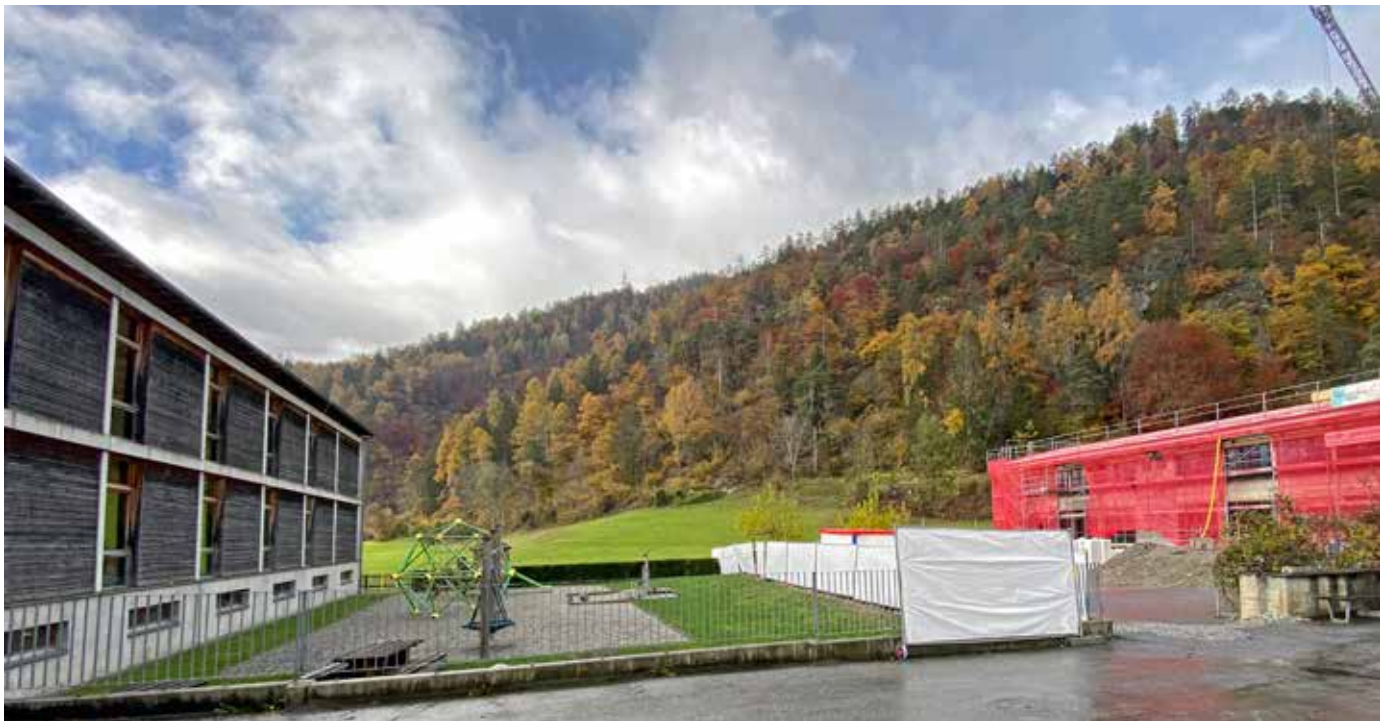
Bei der Renovierung des Schulhauses in Tamins (GR) stand eine Verstärkung des Mauerwerks mit Blick auf mehr Erdbebensicherheit im Vordergrund
