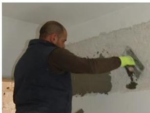
Eine erste Mörtelschicht wird auf die vorbereitete Fläche aufgetragen und fest aufgedrückt. Es ist zu gewährleisten, dass das gesamte Untergrundprofil ohne Hohlräume ausgefüllt ist. Die Schichtdicke sollte 50 - 75 % der gewünschten Enddicke des Mörtel-Verstärkungssystems entsprechen.
