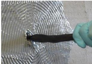
SikaWrap® FX-50 C wird mit einer Stricknadel langsam eingeführt und die Fasern gleichmässig auf der Mörteloberfläche verteilt.
