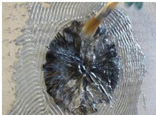
Die verteilten Fasern werden in das Harz auf der Mörteloberfläche gepresst und mit Hilfe eines Pinsels gegebenenfalls mit zusätzlichem Harz getränkt, bis alle Fasern vollständig gesättigt sind.
