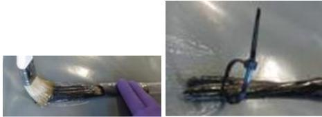
SikaWrap® FX-50 C wird über drei Viertel der Länge mit Sikadur®-330 oder Sikadur®-52 Injection imprägniert, während das restliche Produkt trocken bleibt, damit die Fasern leichter verteilt werden können.
