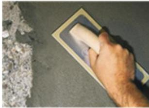
Die Oberflächenvergütung muss mit einem Reibe Brett aus Holz oder Kunststoff erfolgen. Die Mörtelfläche darf nicht mit zusätzlichem Wasser nachbearbeitet werden, da auf diese Weise eine Oberflächentextur mit Zementschlämme entstehen könnte, was zur Rissbildung aufgrund differentiellen Schwindens (Haarrisse) führen kann.
