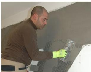
Eine zweite Schicht Mörtel auftragen der das Gitter vollständig einbettet. Es ist darauf zu achten, dass die vorgegebene Gesamtschichtdicke erzielt wird.
