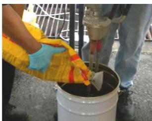
Das Mischverhältnis von Pulver und Wasser muss entsprechend den Temperatur- und Auftragsbedingungen angepasst werden, wobei auch die Topfzeit des Mörtels zu berücksichtigen ist.
