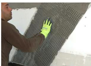
Das SikaWrap®-350 G Grid auf den frischen Mörtel legen und es leicht in die Oberfläche drücken, so dass ein Teil des Mörtels durch die Öffnungen im Gewebe gepresst wird.
