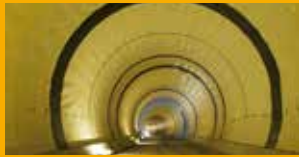
ABDICHTEN IM ERDREICH / GEWÄSSERSCHUTZ
