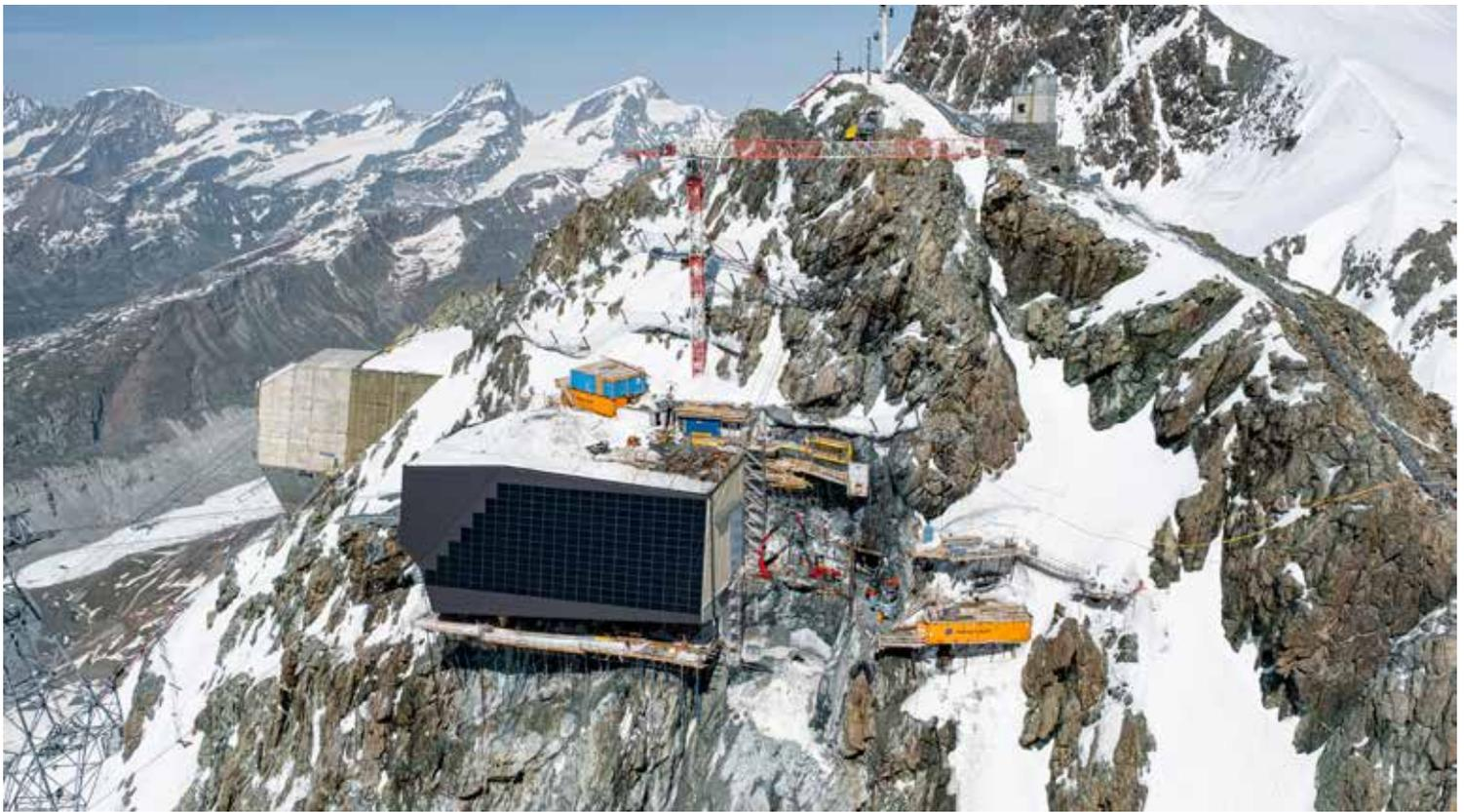
kamen waren Sika® Frostschutz und Sika® ViscoCrete® SB. Für die verschiedenen Mastenfundamente wurden über 2000 m<sup>3</sup> Beton verbaut. Weitere 3000 m<sup>3</sup> für die Tal- und Bergstation. Die neue Bergstation wird direkt an die Bestehende angebaut, so dass beide zu einem Gebäude verschmelzen.
