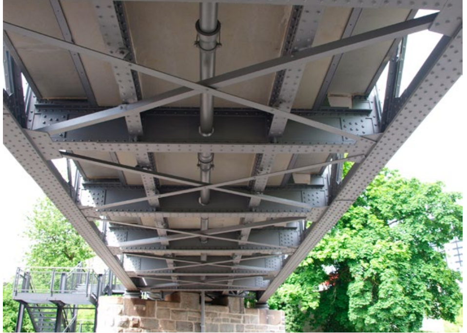
Vista della superficie inferiore del ponte dopo il risanamento completo
