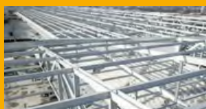
PROTECTION ANTICORROSION ET PROTECTION IGNIFUGE
