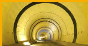
ETANCHEMENT AU SOL / PROTECTION DES EAUX
