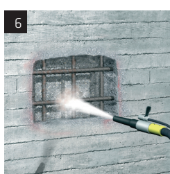
6 Entrosten der Armierungseisen Reinheitsgrad Sa 2 (Verfahren 11.1) bis Sa 2 ½ (Verfahren 11.2) siehe EN 1504-10A.3.3.2
