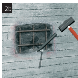
2b Betonabtrag Spitzen.
