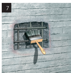
7 Korrosionsschutz SikaTop Armatec-110 EpoCem/ Sika MonoTop-1010 2 x ca. 1 mm
