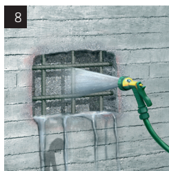
8 Wässern der Betonoberfläche Betonporen mit Wasser füllen. (kein stehendes Wasser)
