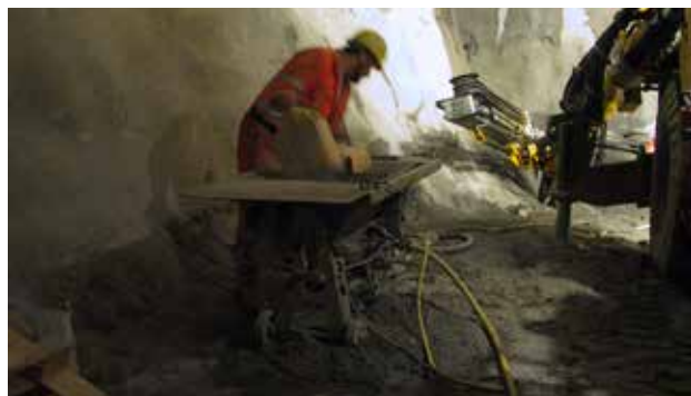
Consolidamento temporaneo con malta spruzzata a secco
