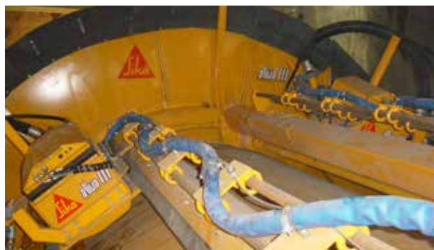
Consolidamento in calcestruzzo spruzzato dietro lo scavo durante l'avanzamento TBM.
