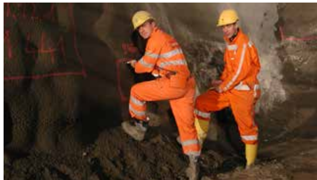
Specialisti Sika sul posto durante il controllo delle resistenze iniziali del calcestruzzo spruzzato.
