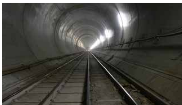
Calcestruzzo per gli anelli interni quale rifinitura finale durabile delle due gallerie.
