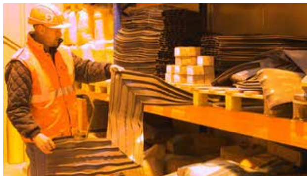
Per essere sempre pronti alla fornitura è stato allestito un magazzino sul cantiere, denominato “Shop on the Job” con i prodotti più importanti.
