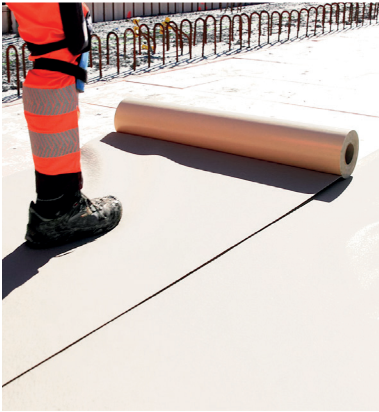
Bei der Abdichtung von Boden- und Wandflächen im Fundamentbereich ist das SikaProof® A+ System erste Wahl.
