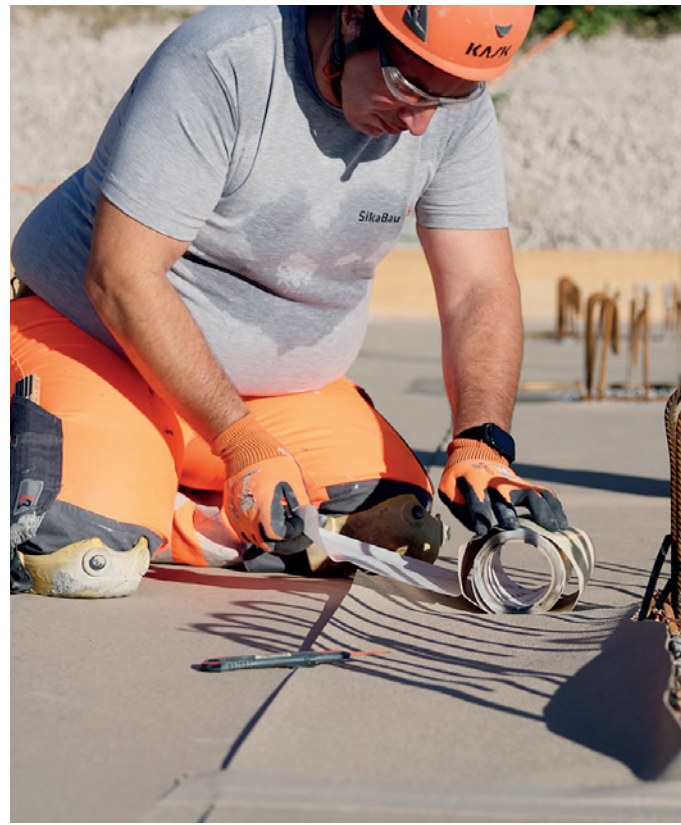
Details und komplexe Geometrien werden weiterhin mit den SikaProof® Tapes abgedichtet.
