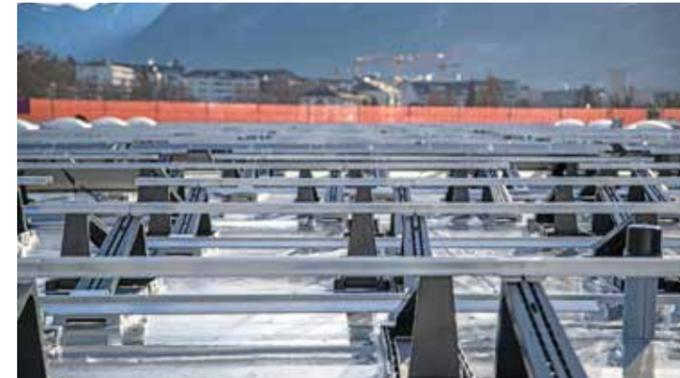
Das Sika® SolaRoof® ist die Sika-Systemlösung für Flachdächer mit Photovoltaik-Installationen. Es bietet ein einfaches Montagesystem, das ohne jegliche Durchdringungen mit wenigen Werkzeugen direkt auf die Sika-Dachabdichtung geschweisst wird. Als Leichtgewicht kann das Sika® SolaRoof® auch auf gewichtskritischen Dachkonstruktionen eingesetzt werden.
