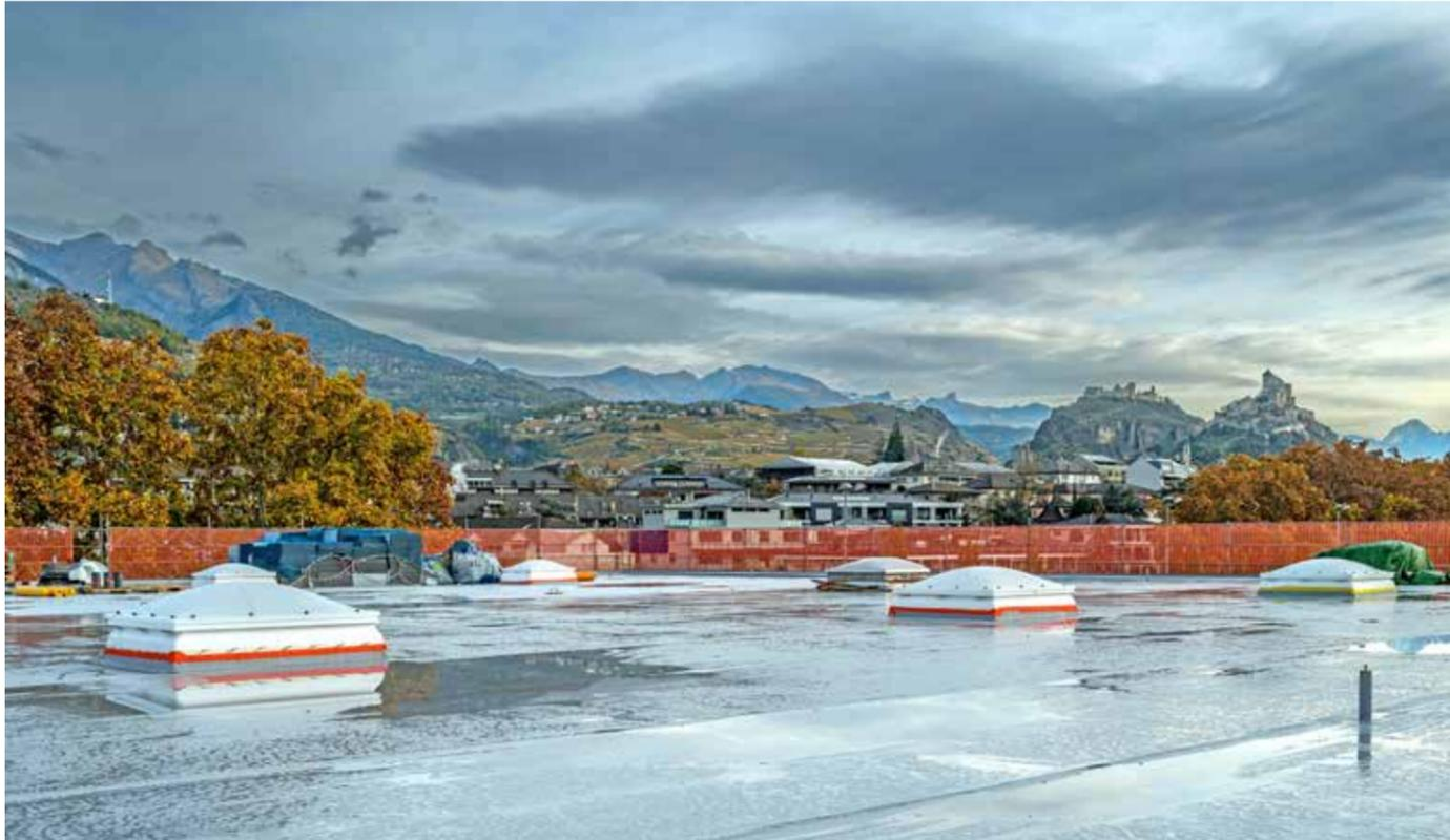
Das Sika Hybrid-FPO-Dachsystem besteht aus wasserdichten Kunststoffdichtungsbahnen auf Basis von flexiblen, thermoplastischen Polyolefinen (Hybrid-FPO). Da die Folie ohne offene Flamme verarbeitet wurde, war die Brandgefahr kein Thema.
