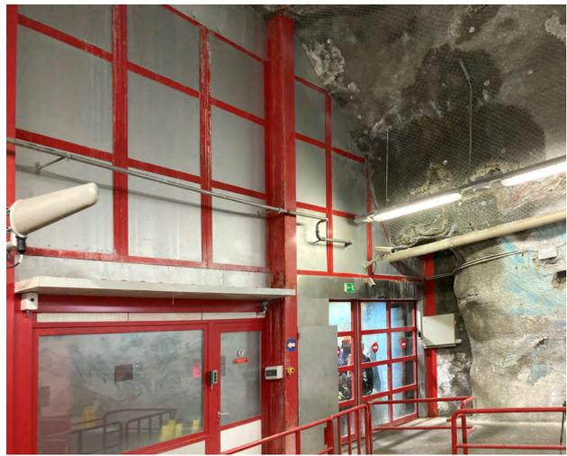
Talstation mit provisorischem Gitter zum Schutz vor Steinschlag
