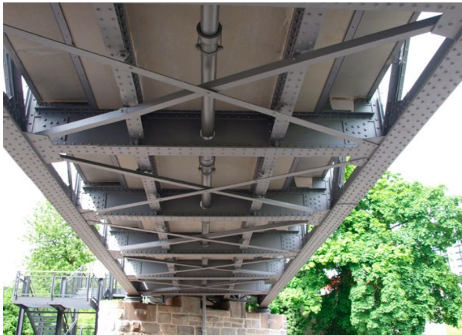
Brückenuntersicht nach der Komplettsanierung.
