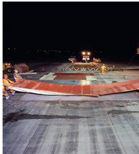
Abdecken einer sanierten Stelle
