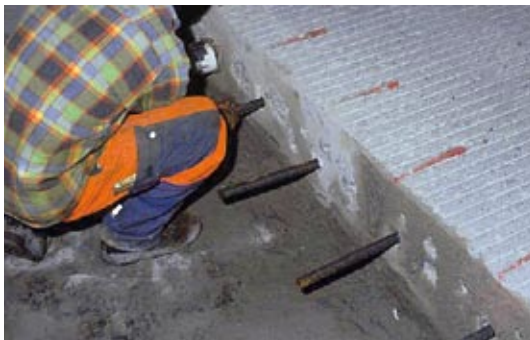
Versetzen der Dübel bzw. Anker
