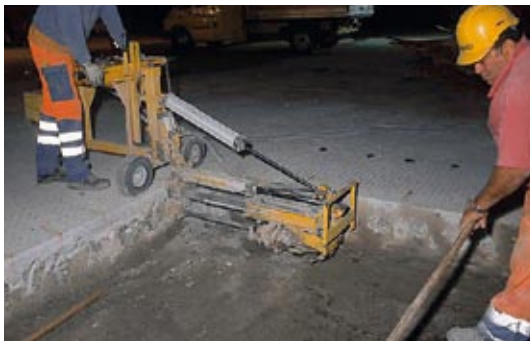
Bohrungen für Dübel bzw. Anker
