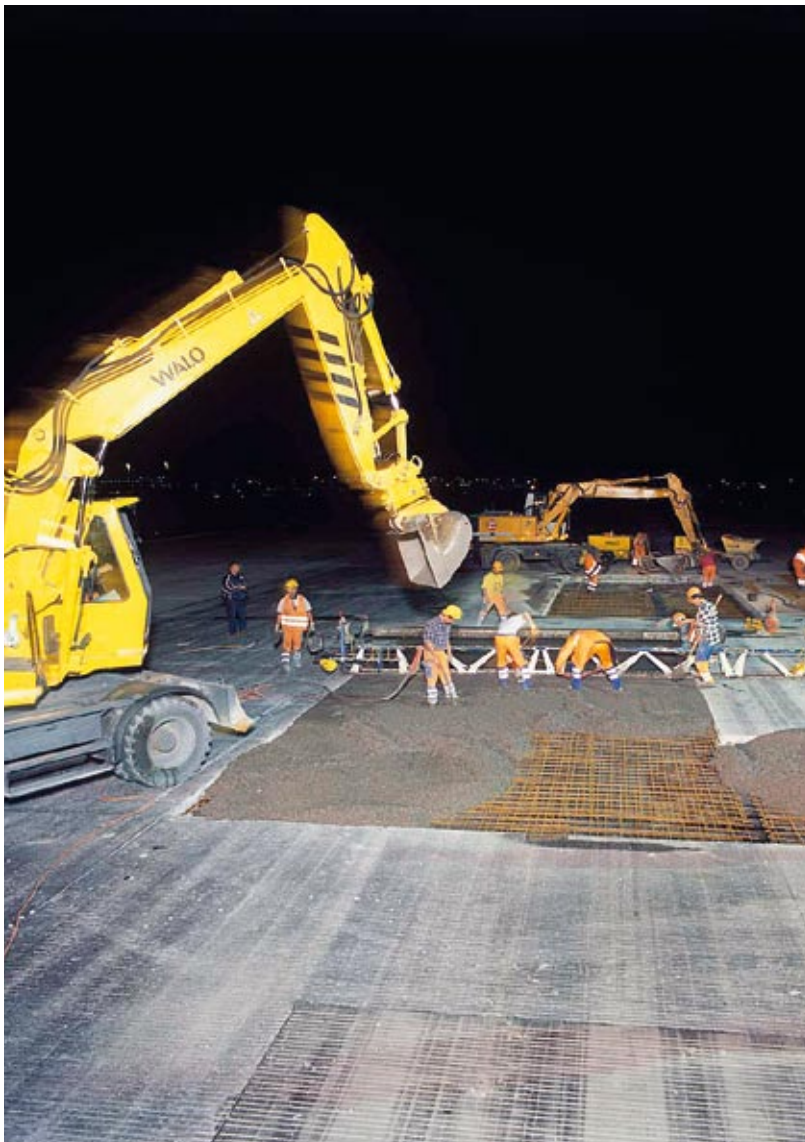
Betonieren von Pistenflicken mit SikaCem ® -501
