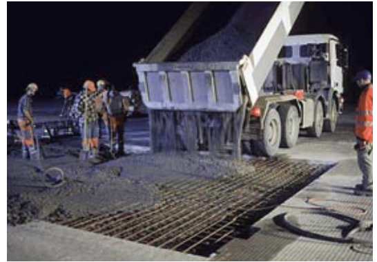
Einbau des SikaCem ® -501 direkt vom Lastwagen
