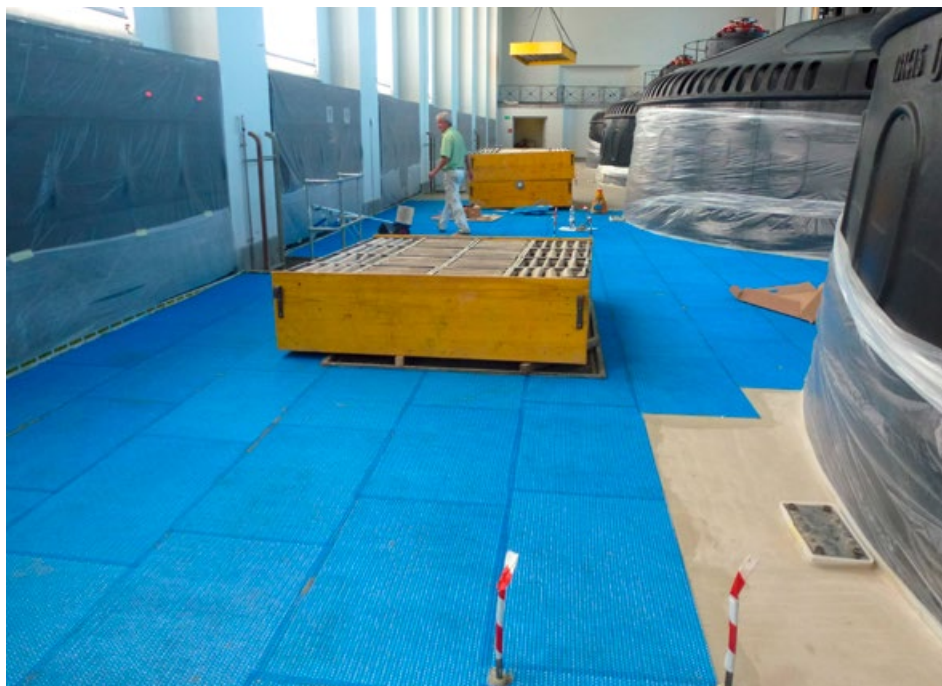
Verlegen der Entkopplungsmatten Sika Permat.
