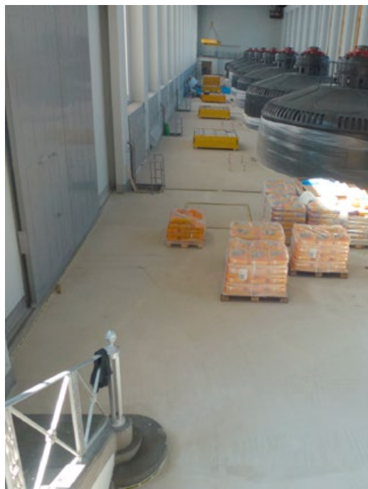
Nivellierter Boden Turbinenraum
