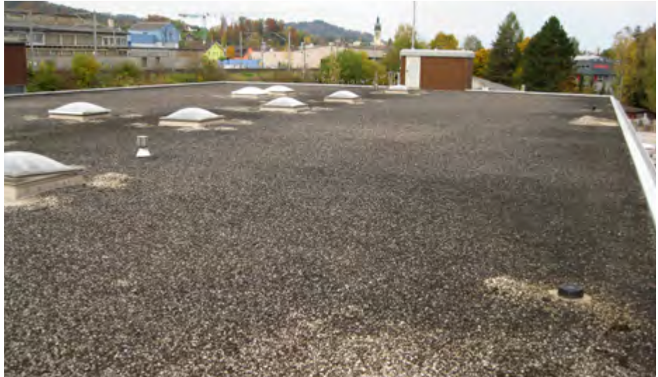
Bild 4: Übersichtsaufnahme Dachfläche des Objekts Brunner in Flawil (Schweiz)
