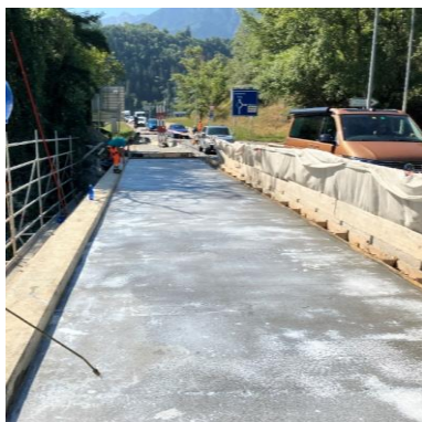
Fig. 29: applicazione di una protezione dall'evaporazione.
