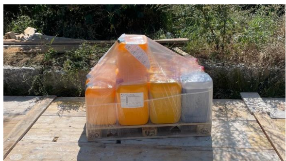
Fig. 5: stoccaggio dei materiali necessari nei pressi del luogo di miscelazione.
