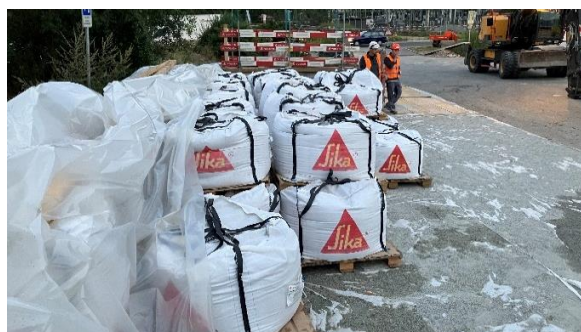
Fig. 4: stoccaggio della polvere nei pressi del luogo di miscelazione.
