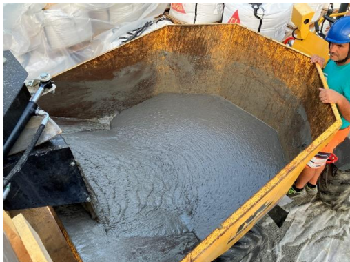
Fig. 15: scarico della miscela in un dumper.
