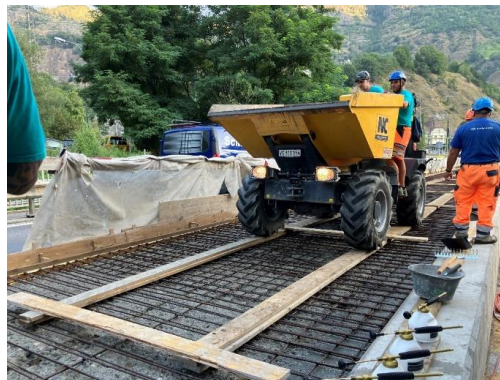
Fig. 16: trasporto con dumper sul sito della posa in opera.
