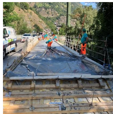
Fig. 31: protezione con pellicola di plastica.
