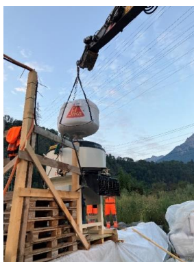
Fig. 12: movimentazione di BigBag con gru/escavatore a pala.
