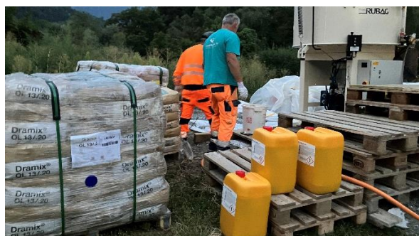
Fig. 3: allestimento/preparazione del luogo di miscelazione.
