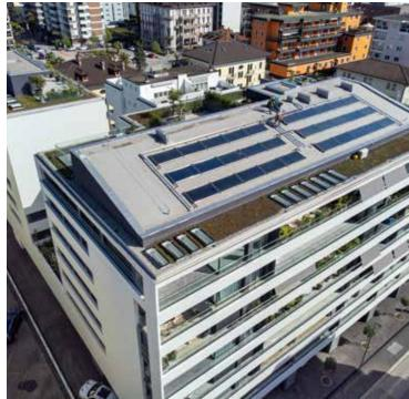
Bei der Abdichtung der Dächer und den Dachgeschossen konnte Sika mit einer Abdichtungsbahn aus Hybrid-FPO-Kunststoff einen wesentlichen Beitrag zur Reduzierung der CO<sub>2</sub>-Emissionen leisten.
