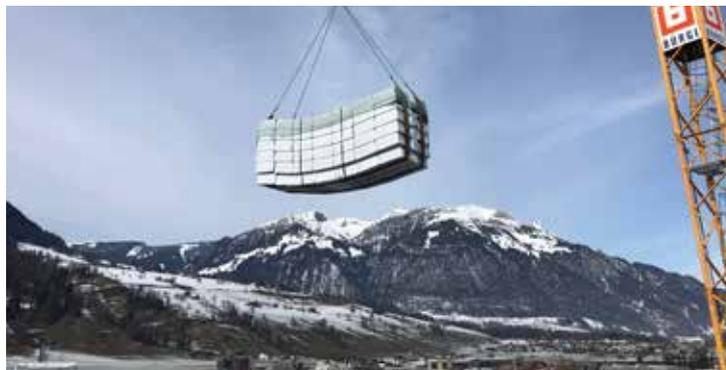
Die EPS Hochleistungswärmedämmung S-Therm Plus konnte mittels dem Transportsystem Volumina direkt vom LKW-Anhänger mittels Kranzug aufs Dach gehoben werden.
