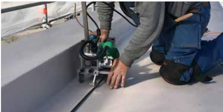
Mittels den bewährten Leister-Schweissgeräten konnten die Sika-Abdichtungsbahnen zuverlässig und effizient verschweisst werden – auch bei winterlichen Bedingungen.
