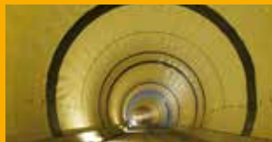
ETANCHEMENT AU SOL / PROTECTION DES EAUX
