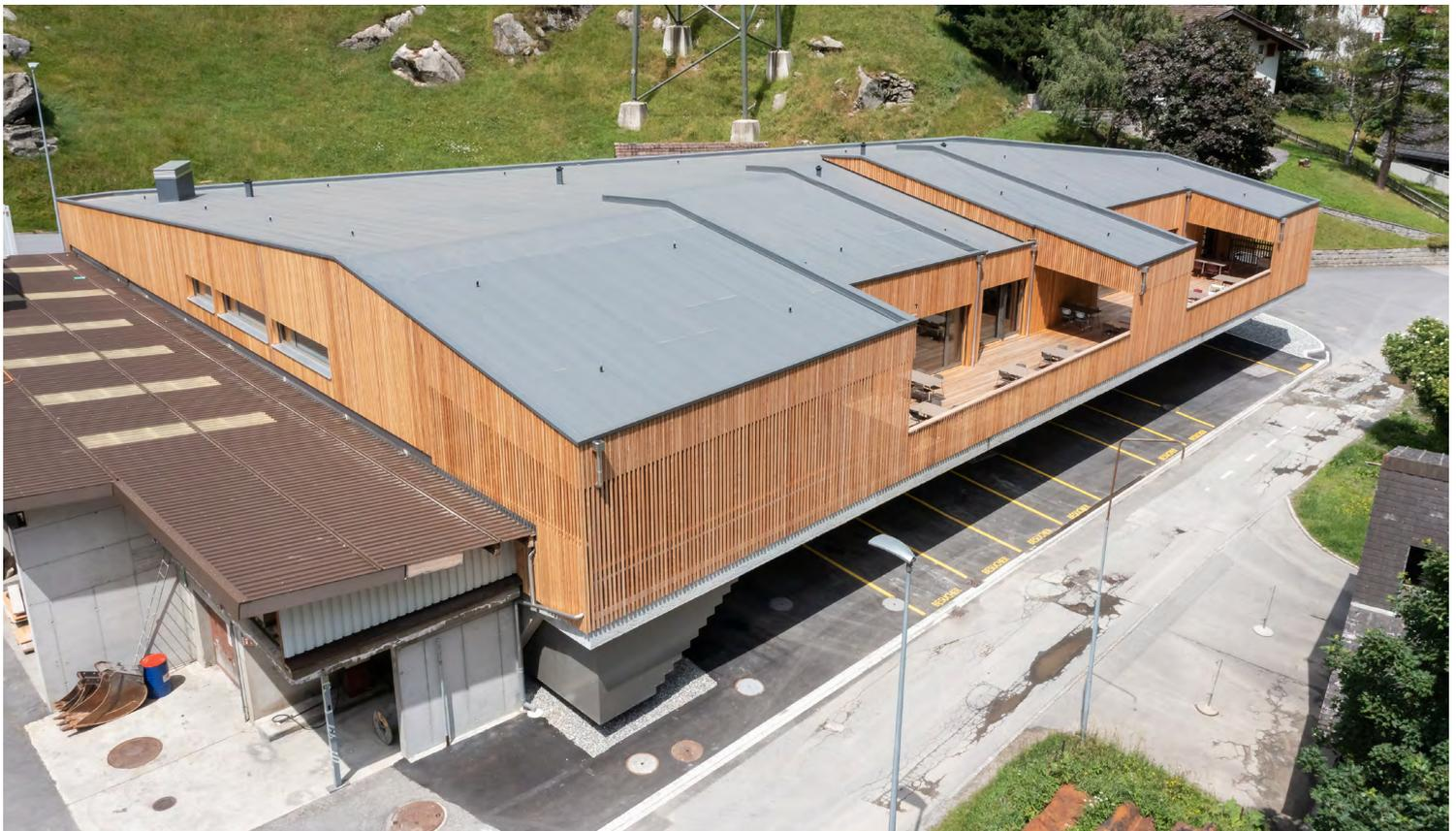
Der spezielle Aufbau von Sarnafil® S 327-18 EL (bleigrau) mit reissfester Polyester einlage inklusive Zubehör ist für Flachdächer mit mechanischer Befestigung konzipiert.
