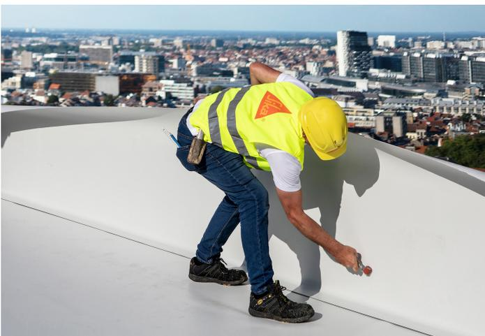
Revolutionäre Systemkomponenten wie die Selbstklebebahn SikaRoof AT FSA P für Aufbordungen ergänzen das Dachsystem der nächsten Generation!
